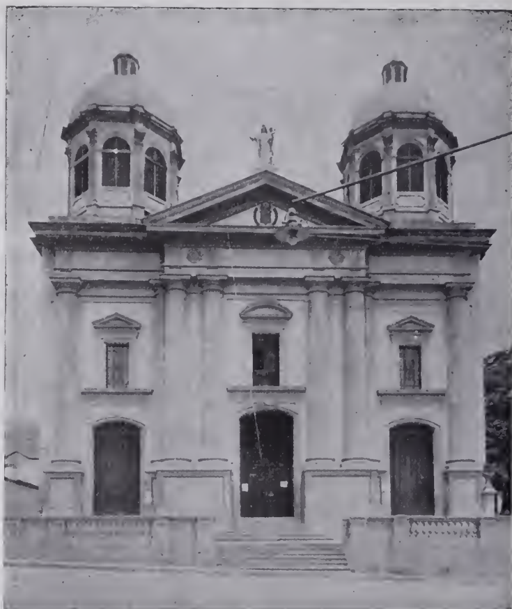
Fachada principal de La Merced, cuyas torres fueron también reformadas en los años 1952-53, cambiándoles su estructura de madera y zinc en cemento armado.
